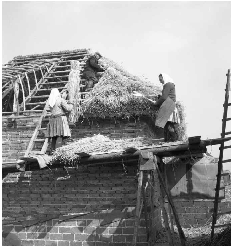
Pracovníci JZD Lipov při pošívání střešy došky v muzeu v přírodě ve Strážnici, foto Josef Jančář, 1975 (Fotoarchiv NÚLK Strážnice)
